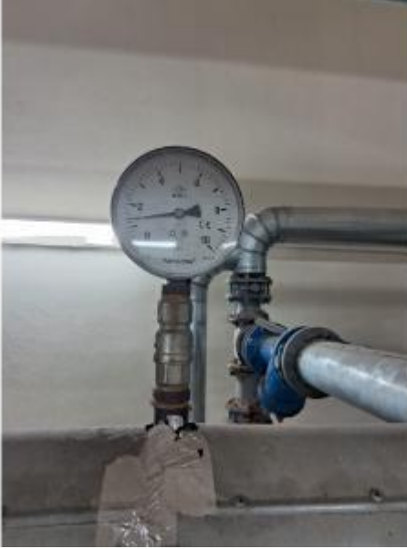
Elektrik Görsel Kanıtlar
